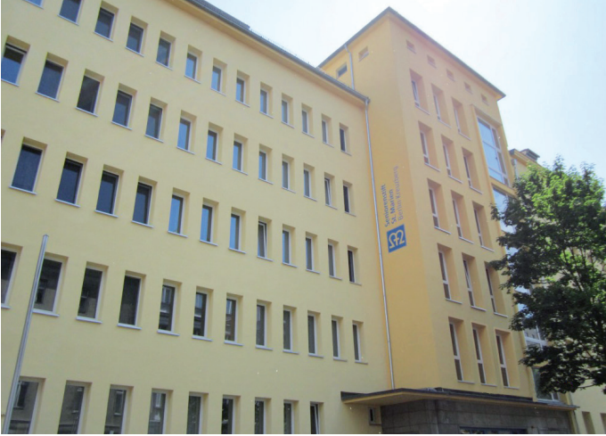
Die neue Fassade des Seniorenstift St. Marien in Kreuzberg
